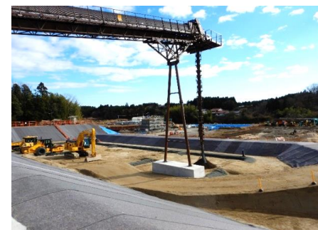
土壌貯蔵施設（双葉工区）
