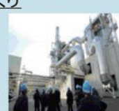
バイオマス発電所
